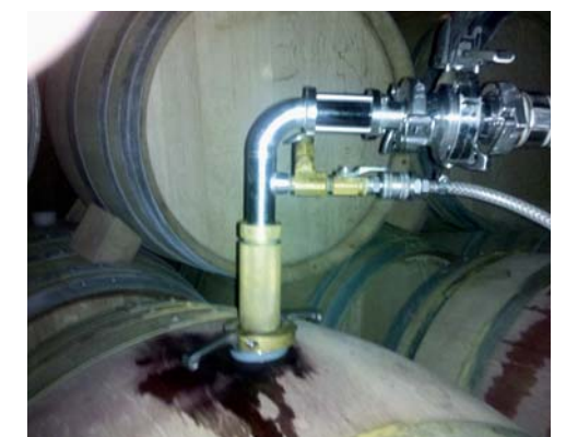
Obr. 9-18: Zařízení pro čištění sudů
