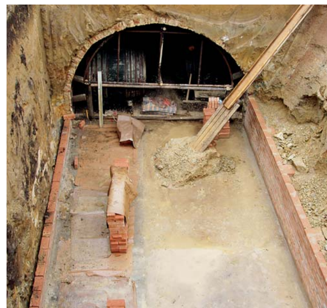
Obr. 14-5: Výkop s vyzděnými klenebními pasy
