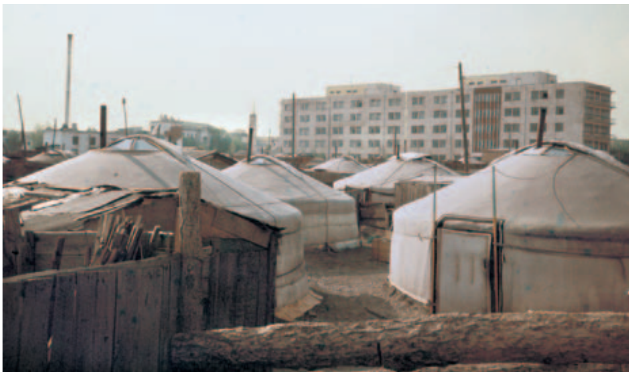
Příklady různých typů východních i západních jurt. Rákosové vertikální stěny kryjící mřížovou kostru mohou být v případě potřeby omítnuty proti chladu.
