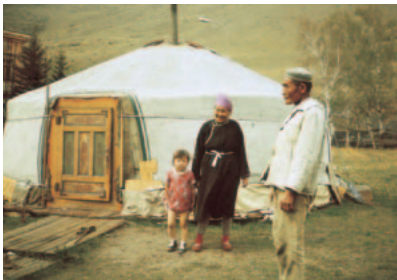
Turkmenský typ jurty. Zajímavé je zpevněné orámování dveří a obvodové (dolní) utěsnění. Na zimu se pro zateplení přidává i několik dalších plstěných krytín.
